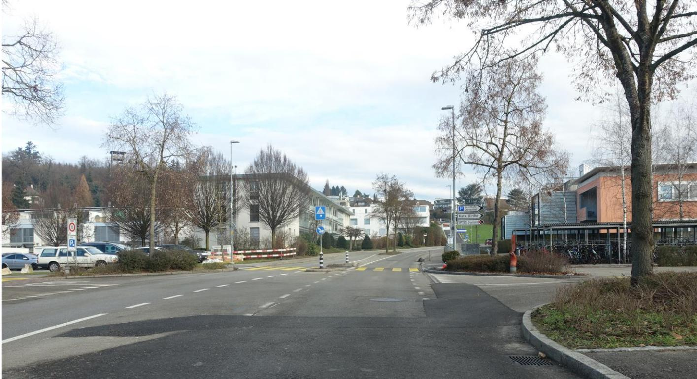
Die Sicht zwischen dem Fahrverkehr in Richtung Norden/Büetigen und dem östlichen Annäherungsbereich des Fussgängerstreifens ist ungenügend. Die freie Sicht beträgt etwa 25-30 Meter. Die Sicht kann zusätzlich durch wartende Fahrzeug an der Einmündung «Grentschelstrasse» eingeschränkt werden. Alle weiteren Sichtweiten am Fussgängerstreifen sind eingehalten.
