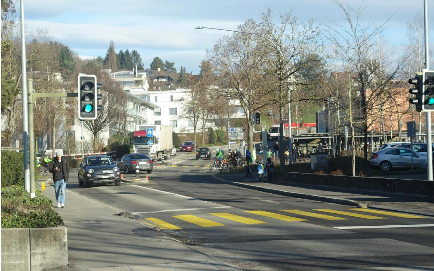
Lichtsignalanlage als reine Bedarfs-LSA: Dauergrün entlang der Kantonsstrasse, das nur nach FG-Anmeldung unterbrochen wird.
