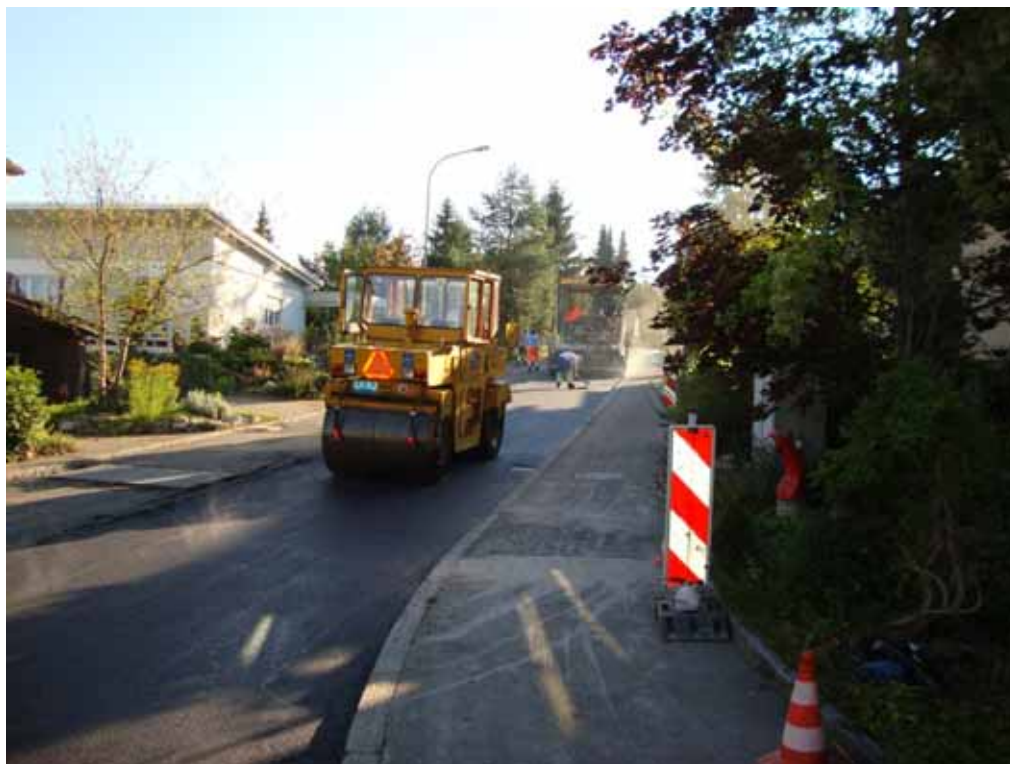
Belagseinbau am Rossiweg in Lyss
