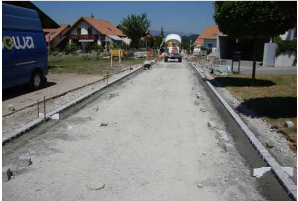
Randabschlüsse der Dotzigenstrasse
