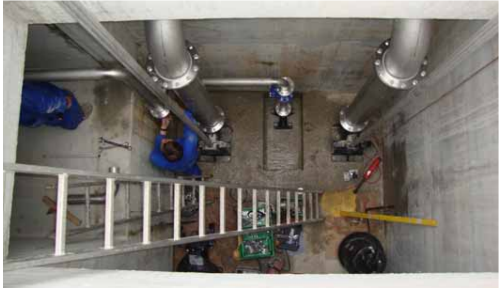
Montagearbeiten im neuen Entlastungspumpwerk Grenzstrasse
