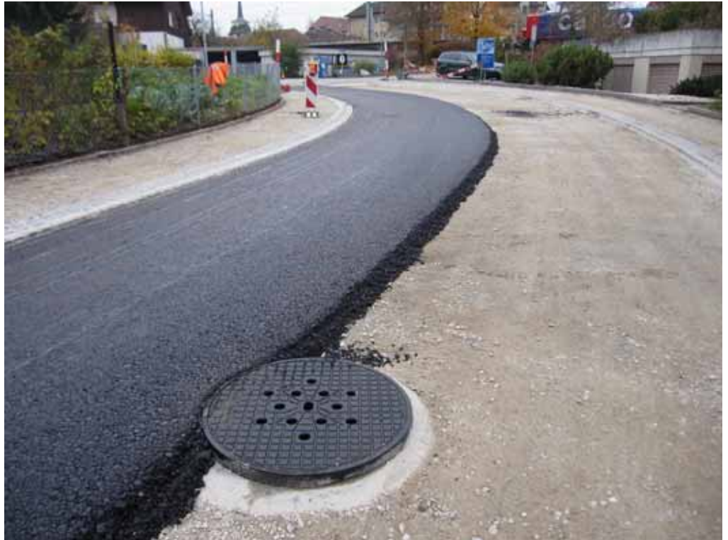
Die Tragschicht einer Fahrbahn des Oberfeldwegs ist bereits eingebracht
