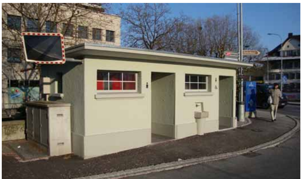
Öffentliche WC-Anlage Aarbergstrasse 16a
