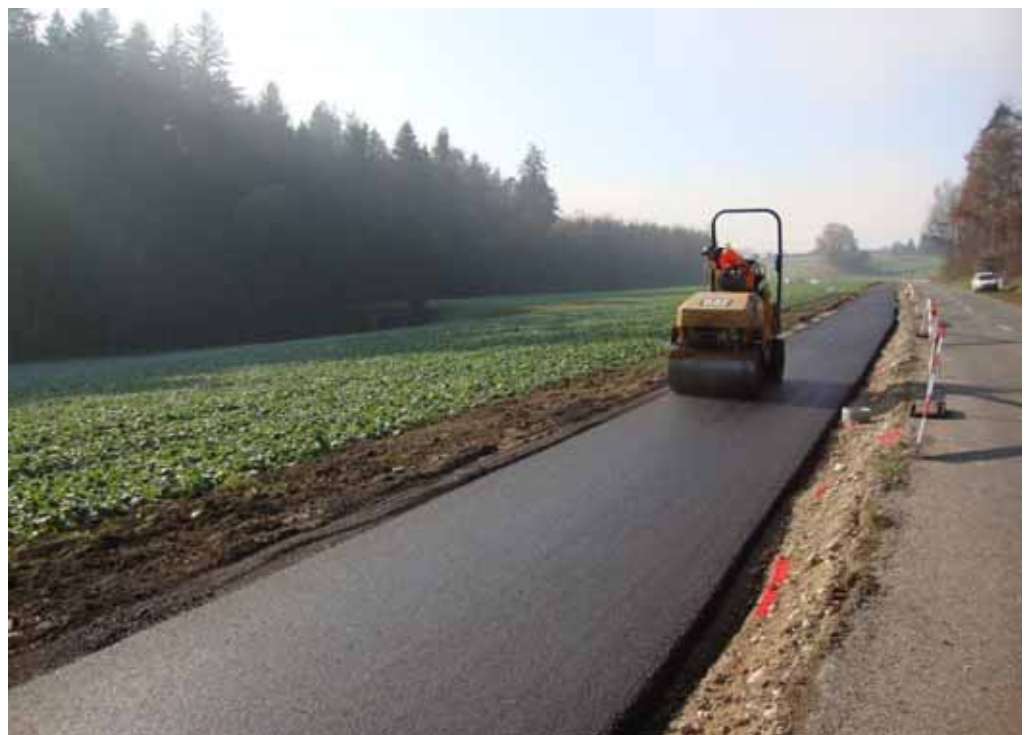
Belageinbau des Fuss- und Radwegs
