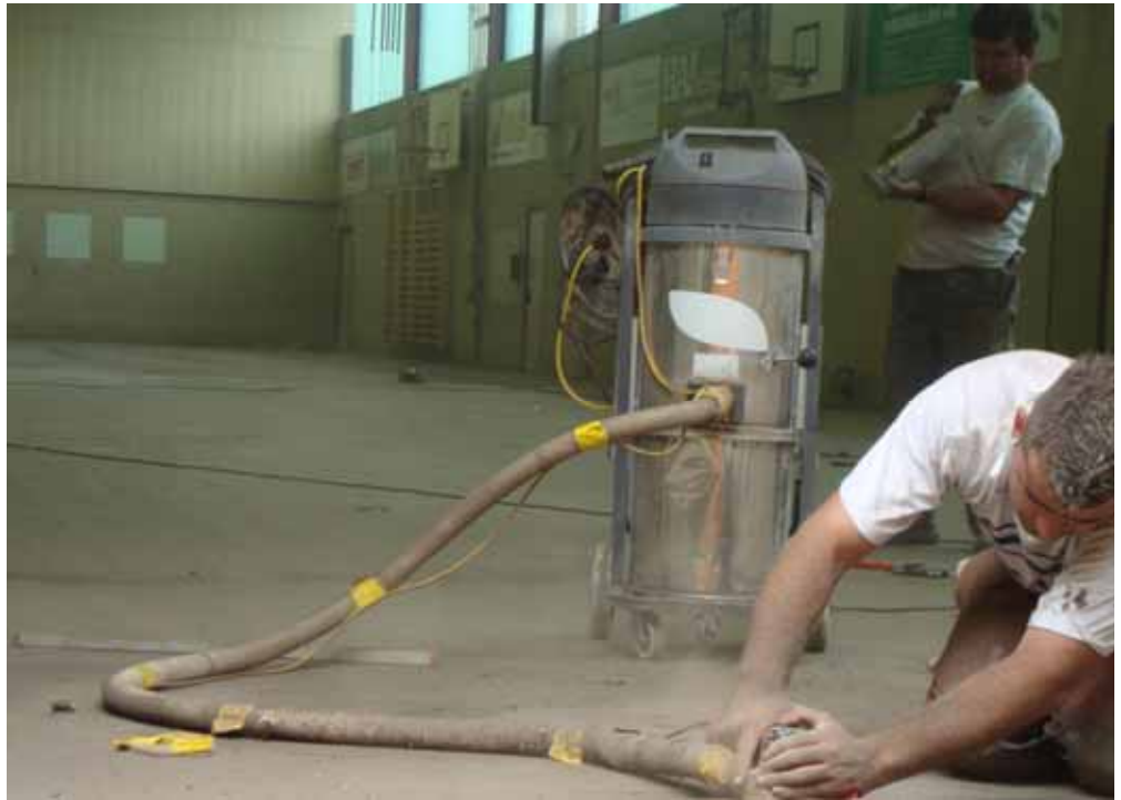
Neuer Hallenboden im Sportzentrum Grien
