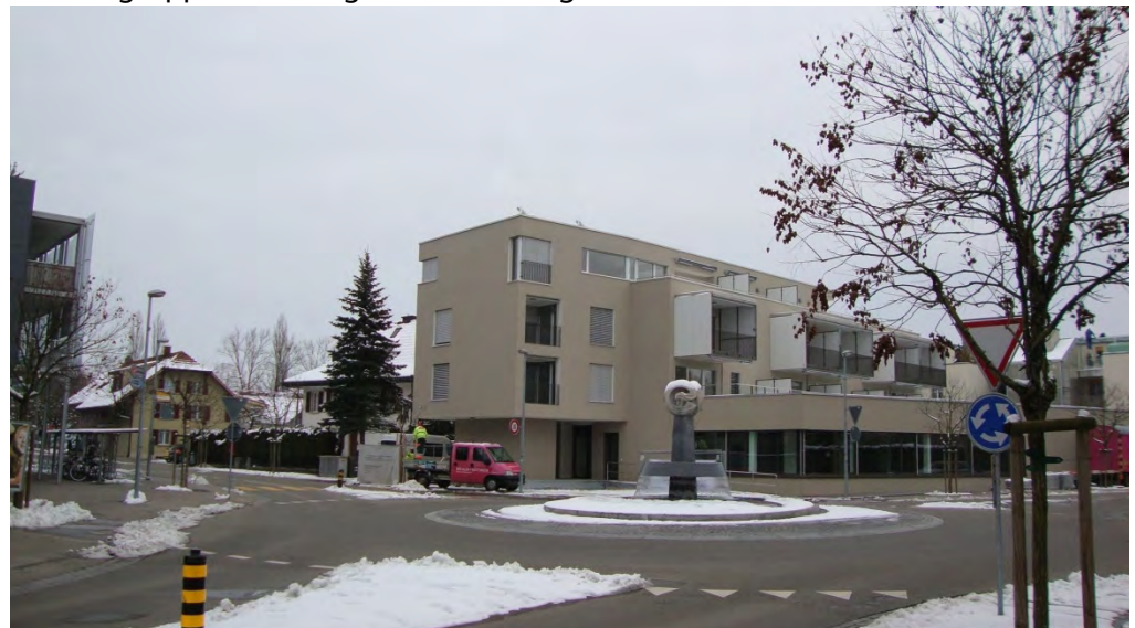
Neubau Wohn- und Geschäftshaus Aarbergstrasse 35
