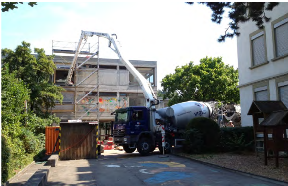
Pumpbeton für zus. Verstärkungen – damit das Gebäude erdbebensicher ist.
