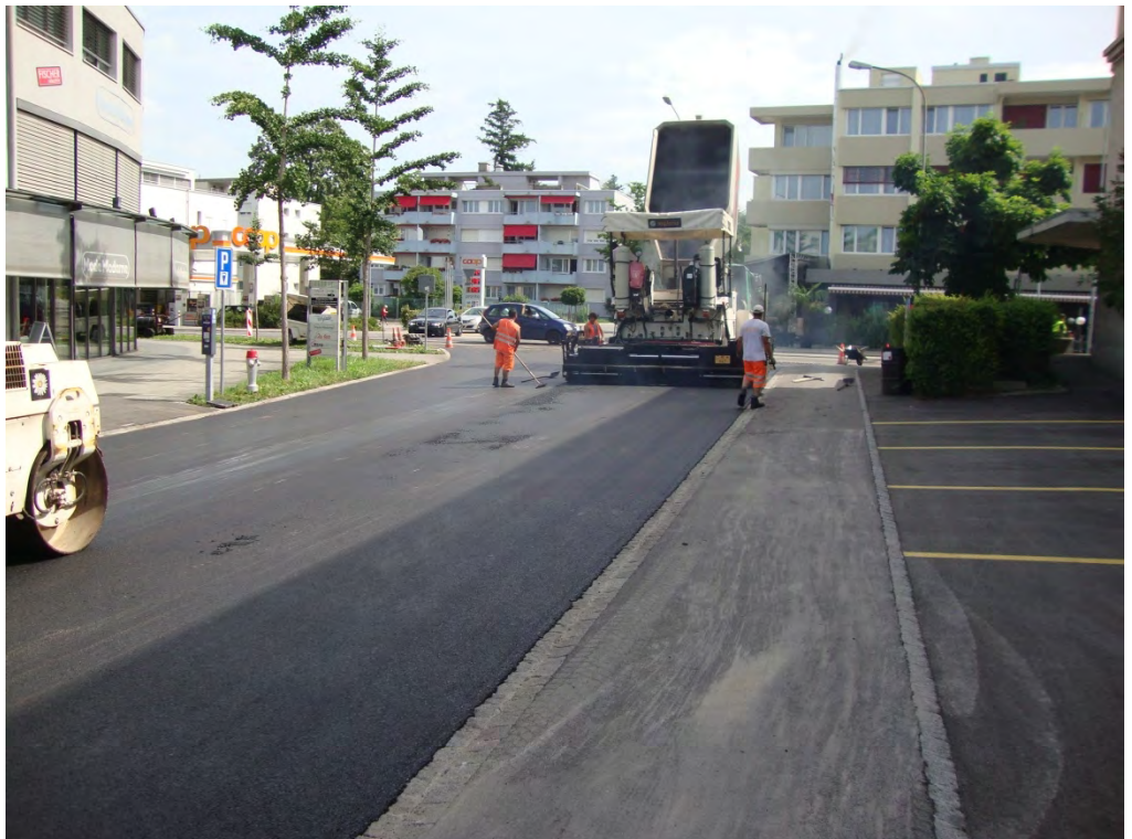
Deckbelagseinbau am Birkenweg
