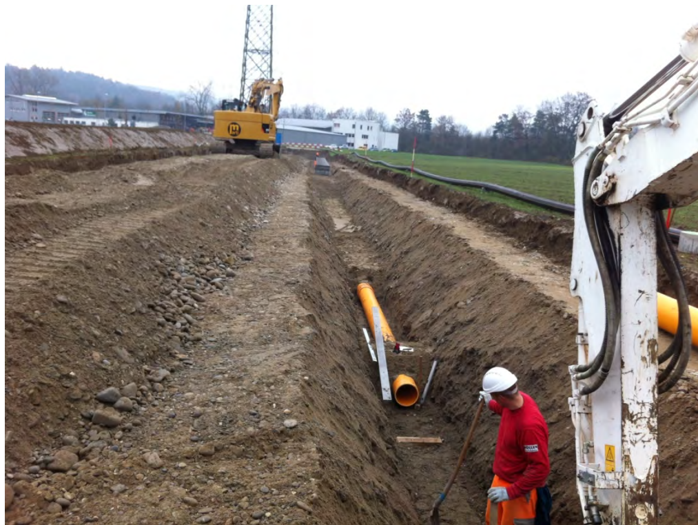
Verlegen der Kanalisation Südstrasse
