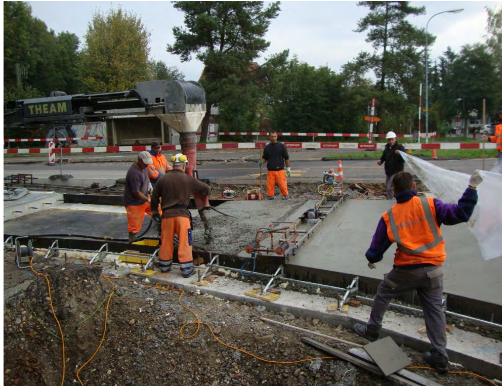
Betonieren der Fahrbahnplatte des Schachenkreisels
