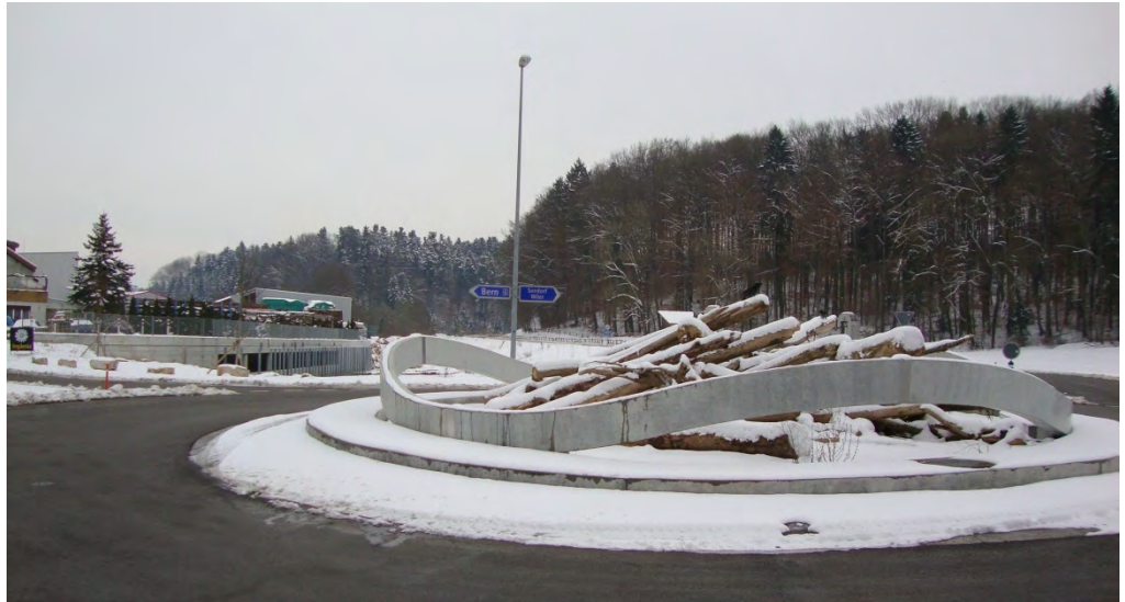
Leenkreisel mit Stolleneinlaufbauwerk
