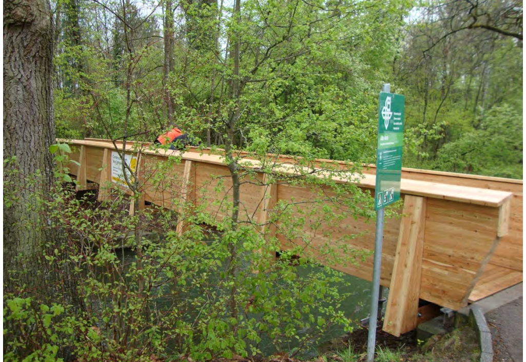
Neue Fussgängerbrücke Alte Aare in Lyss
