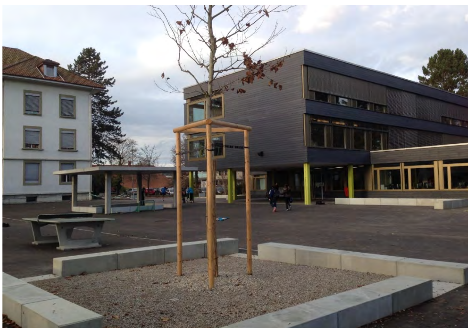
Fertig sanierte Schulanlage Kirchenfeld
