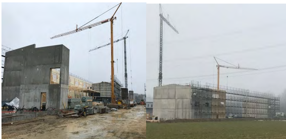
Neubau Werkhof Südstrasse
