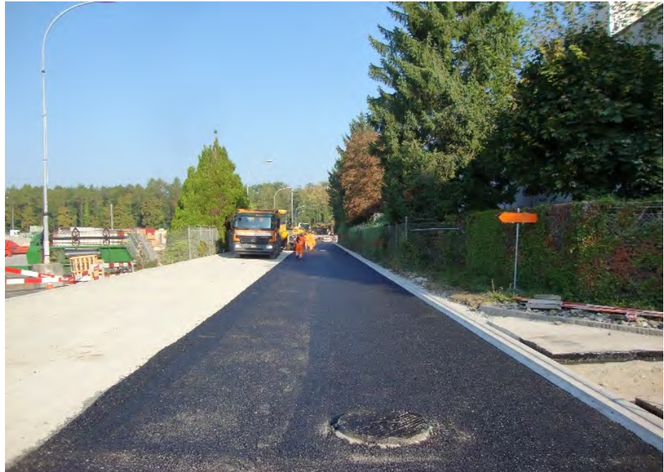
Belageinbau im Industriering
