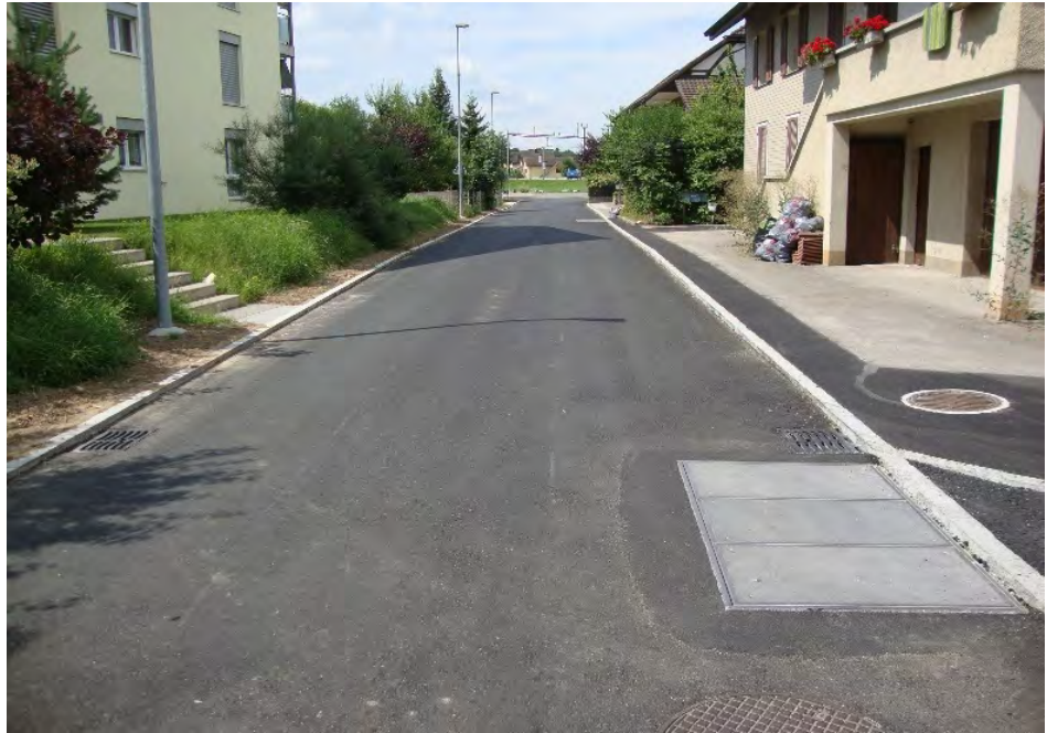
Neuer Belag auf der Fabrikstrasse Busswil
