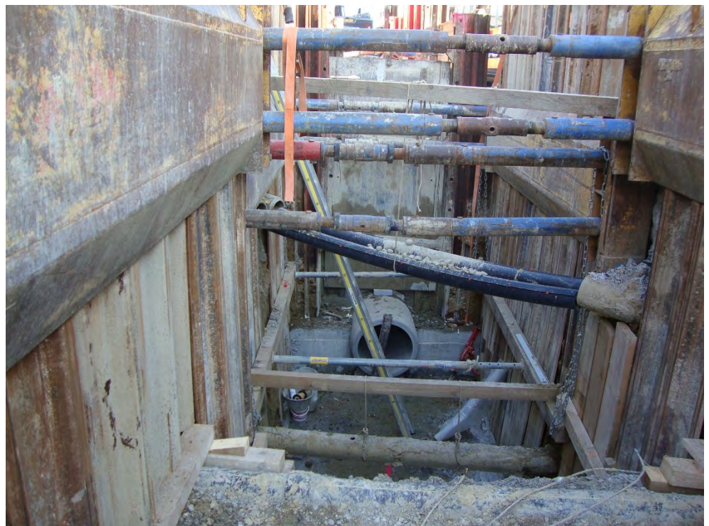
Tief unter der Fahrbahn der Bielstrasse: Die neue Kanalisation
