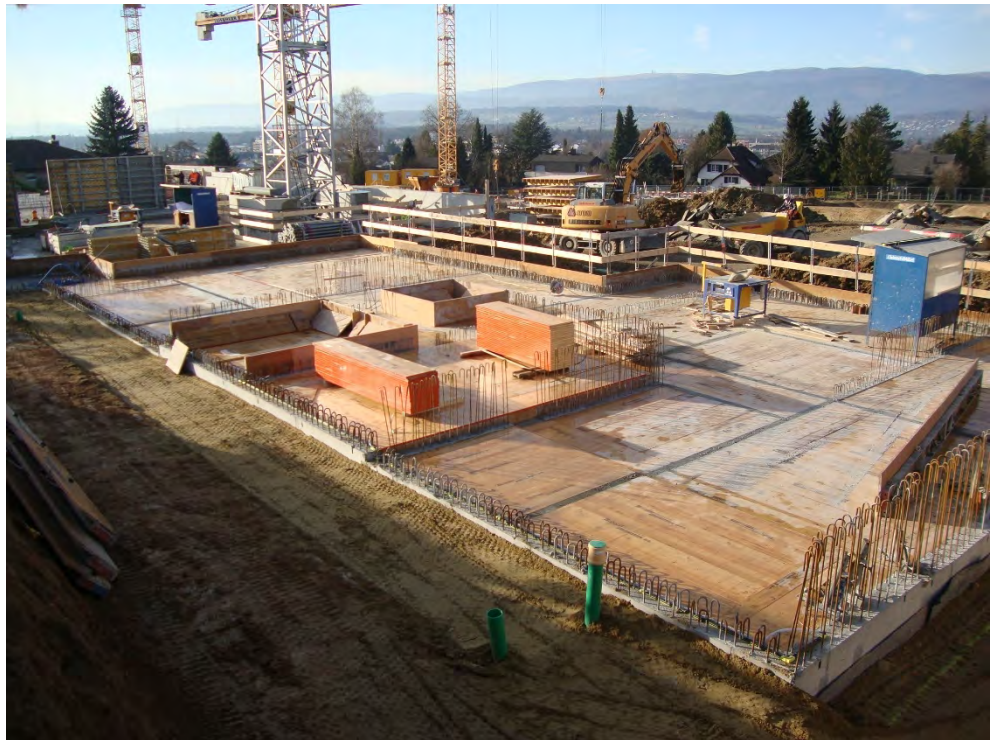
Baustelle Überbauungsgebiet „Rossi“
