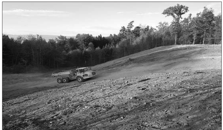
Abtrag des Oberbodens nach der Rodung in der Etappe 6 Richtung Busswil
