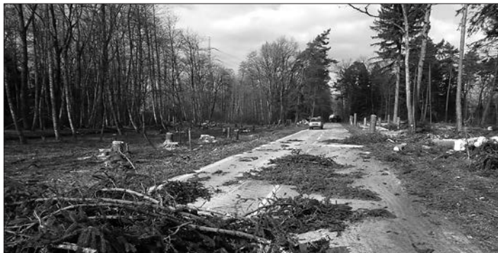
Rodung für die Überlaufmulde und die Strassenabsenkung Richtung Seeteufel
