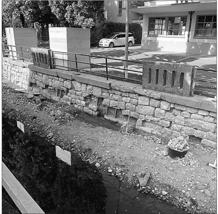
Mauersanierung Lyssbach / Bereich Schulgasse
