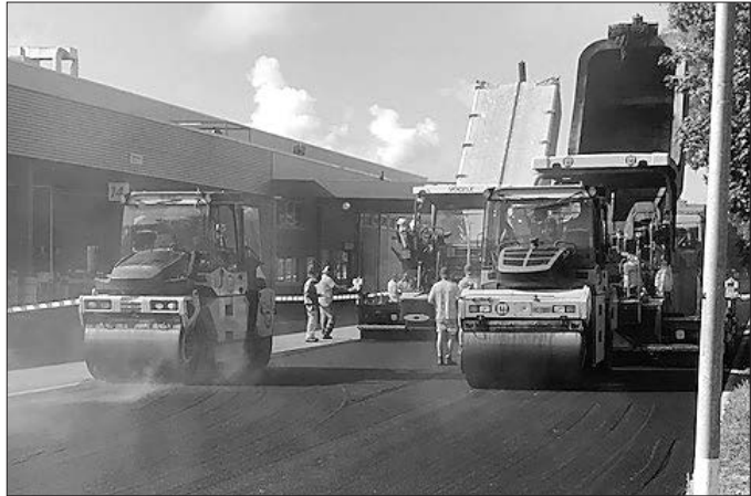
Belagseinbau Industriering Teil Süd
