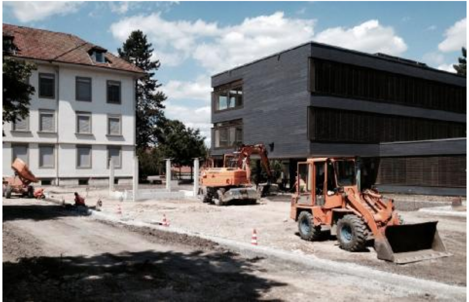
4. Etappe, alle Arbeiten am Pausenplatz mussten während den Sommerferien durchgeführt werden
