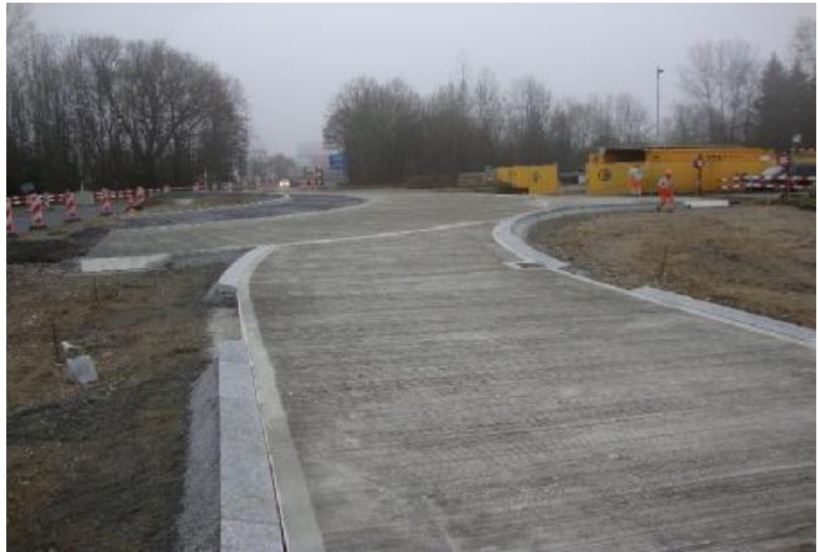
Der „Schwimmbadkreisel“ beim Anschluss Lyss Nord nimmt Form an
