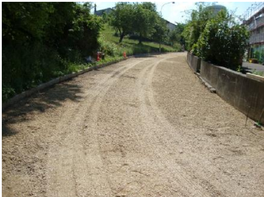
Ein Teil des Haldenwegs vor dem Belageinbau
