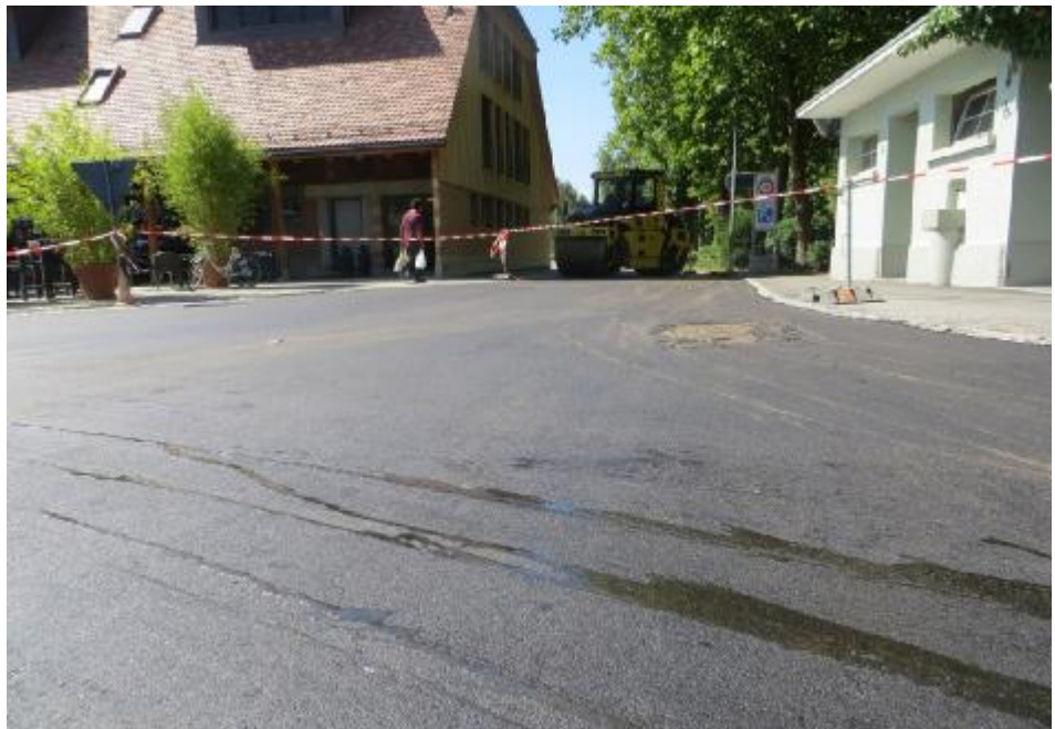
Deckbelag eingebaut bei Kreuzung Aarbergstrasse/Zeughausstrasse. Der Anschluss Herrengasse/Aarbergstrasse wurde kurz nachdem dieses Foto entstanden ist, erstellt.
