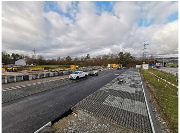
Einbau der neuen Linux-Rasensteine beim Aarepark
