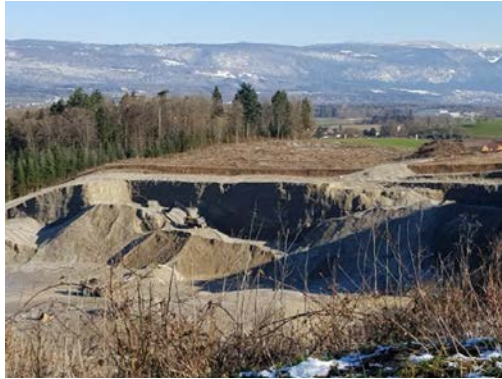
Abtrag des Oberbodens nach der Rodung in der Etappe 6 Richtung Busswil
