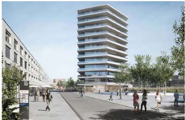
Hochbau beim Lyssbachpark
