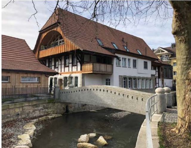
„Brücke Hans Wüthrich“ bekannt als „Mussolini“ Fussgängerbrücke
