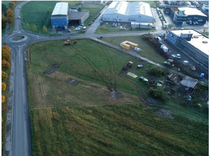
Drohnenaufnahme des Sanierungsperimeters der Deponie Grien
