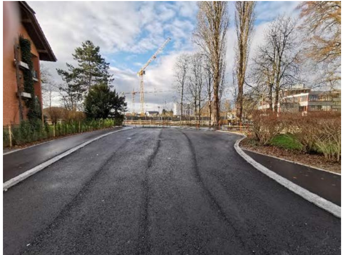
Neu gestalteter Birkenweg nach Einbau der Tragschicht
