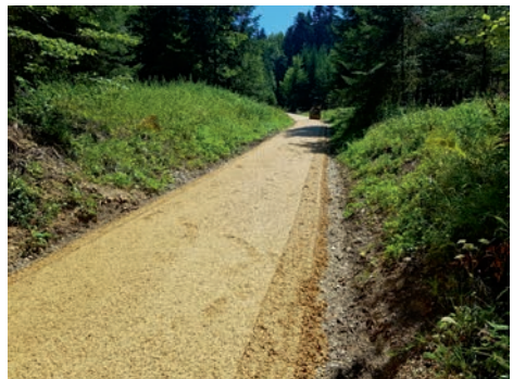
Busswilweg, verdichten der neuen Verschleisschicht
