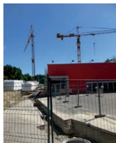
Baustelle Schulhausneubau Grentschel
