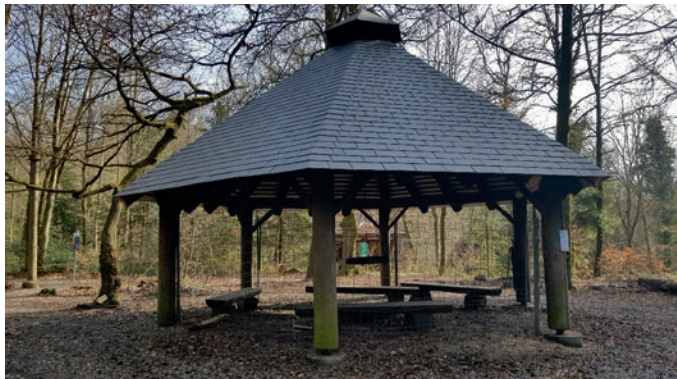
Pavillon mit renoviertem Dach
