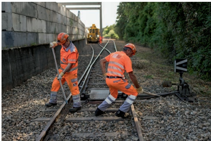
Unterhalt Industriegleise durch Baugruppe SBB
