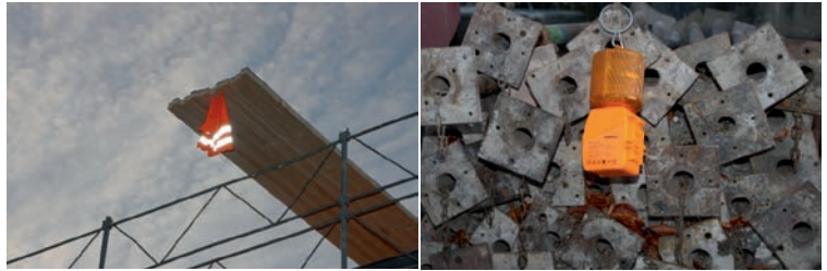
Baustelle Sanierung Schule Stegmatt
