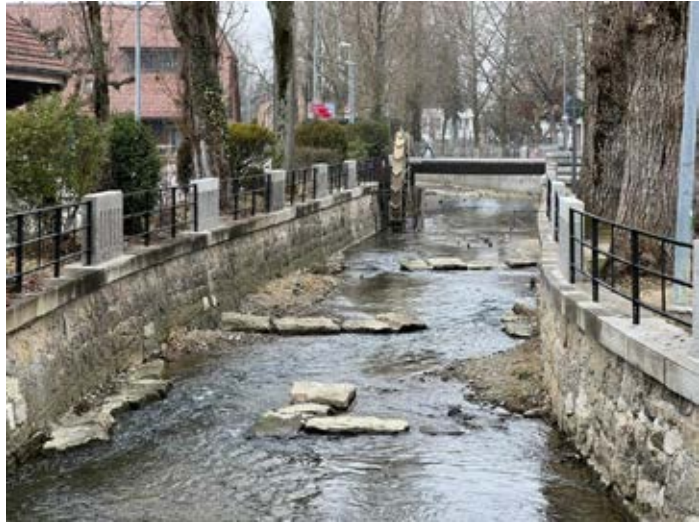
Neue Brüstungen und Geländer entlang des Lyssbachs
