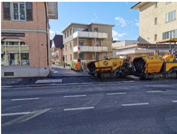
Hauptstrasse Deckbelagseinbau Gehweg
