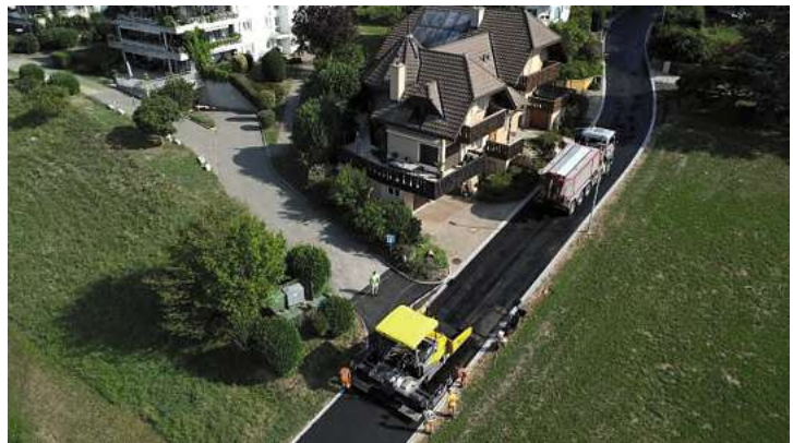
Deckbelageinbau Hübeli
