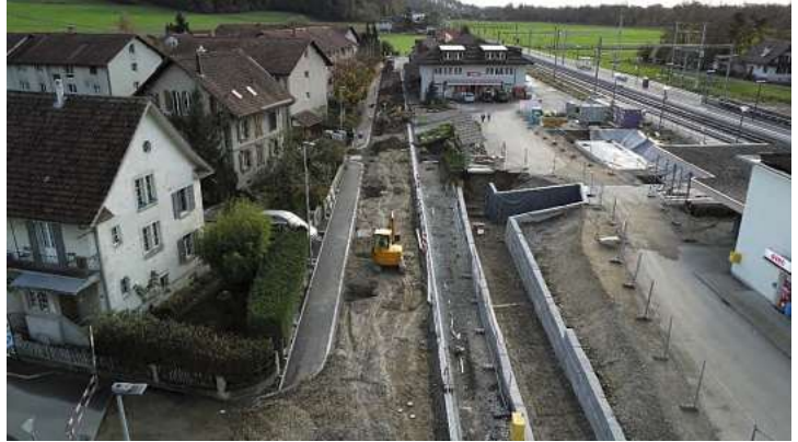
Baustelle Bahnhofgebiet Busswil
