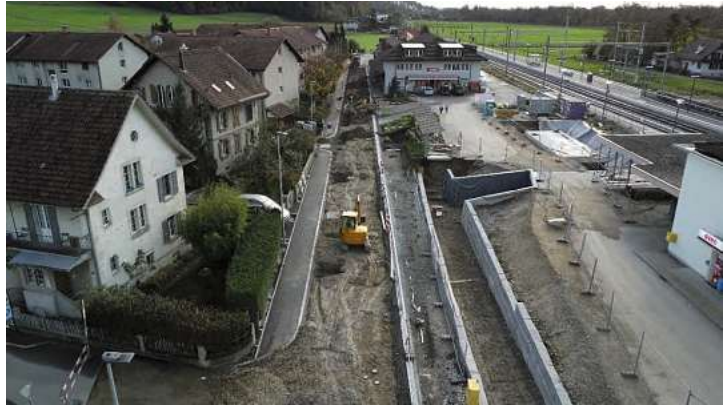
Baustelle Bahnhofgebiet Busswil
