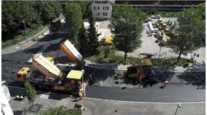
Deckbelageinbau Hauptstrasse
