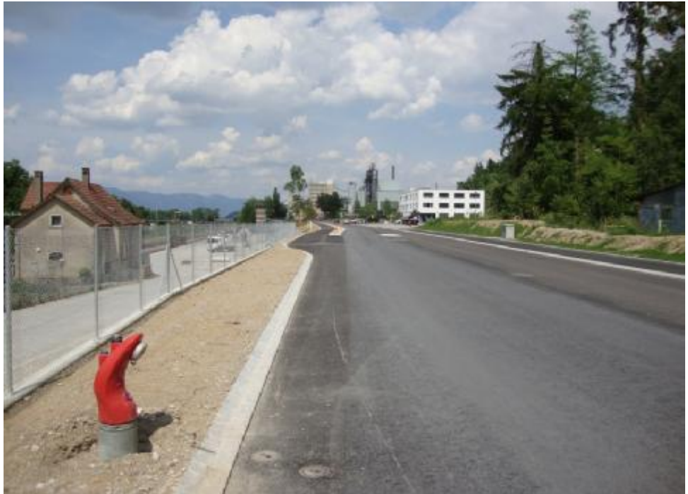
Die neue Busswilstrasse vor den Markierungen
