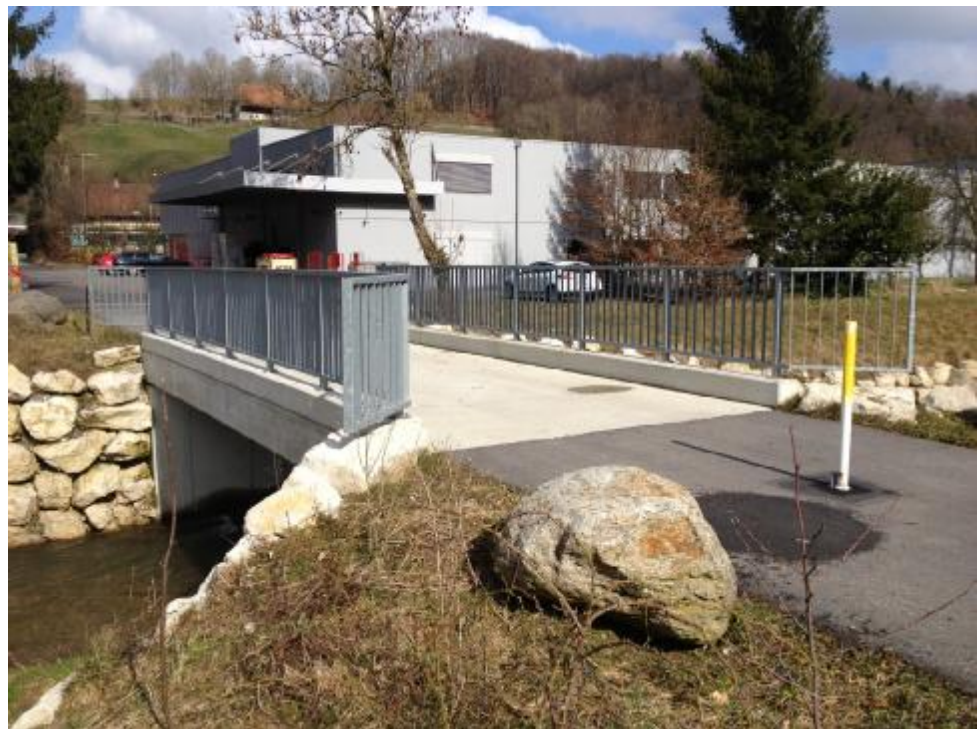
Beispiel einer Brücke in gutem Zustand (Bernstrasse)
