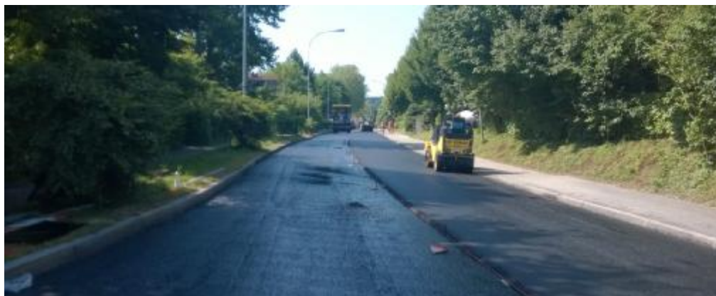
Deckbelagseinbau Aarbergstrasse 2014 nach Wasserleitungsbruch 2014
