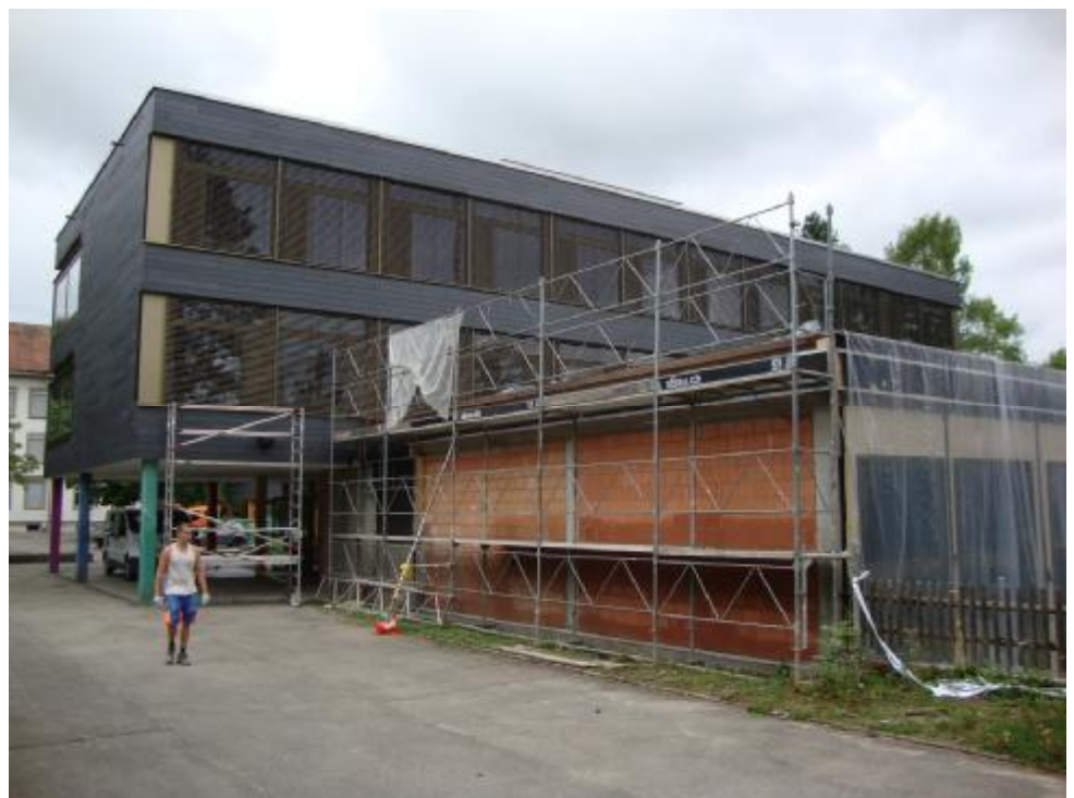
3. Etappe, Aula und Sporttrakt werden saniert
