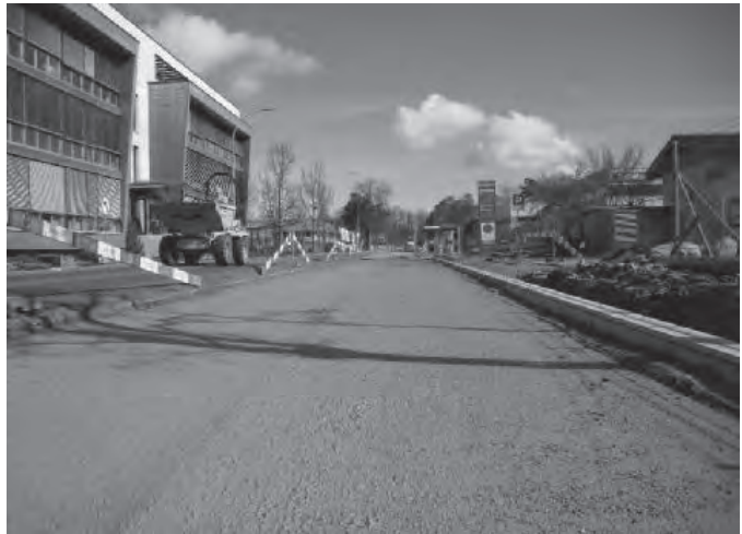
Strassenplanie mit neuer Entwässerungsrinne
