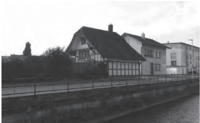
Teilabbruch und Errichten einer Wohnüberbauung Zeughausstrasse 3-7
