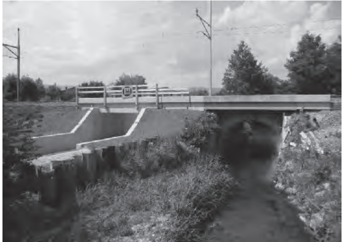
Die neue Personenunterführung neben der sanierten SBB-Brücke über den Lyssbach
