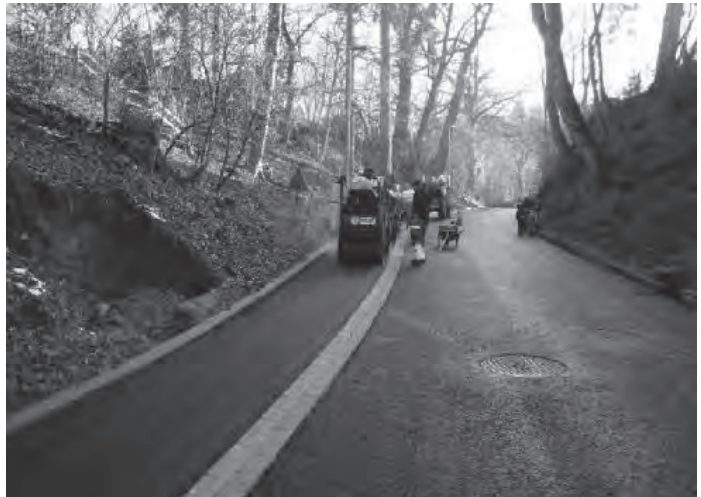
Belagseinbau am Friedhofweg
