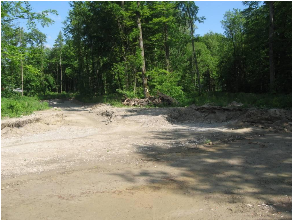
Abb. 2 Renaturierung im Zusammenhang mit dem Bau des Lyssbachstollens (Auslaufbereich in der Fülenmatt)
