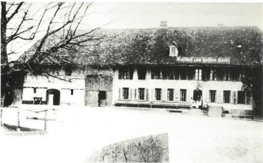
Zustand vor 1903 mit Stallungen, Tenne und Brunnen auf dem Platze
