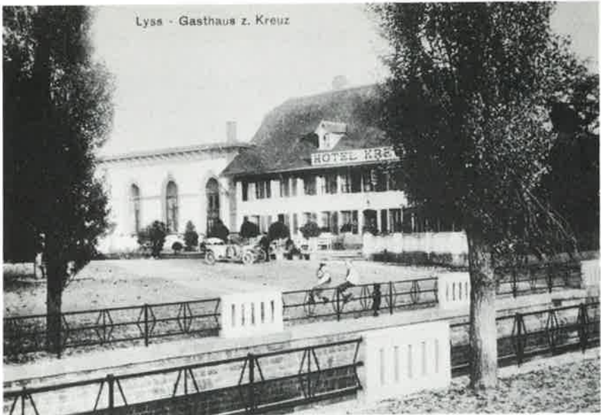
Zustand nach der ersten Renovation, Korrigierter Lyssbach
