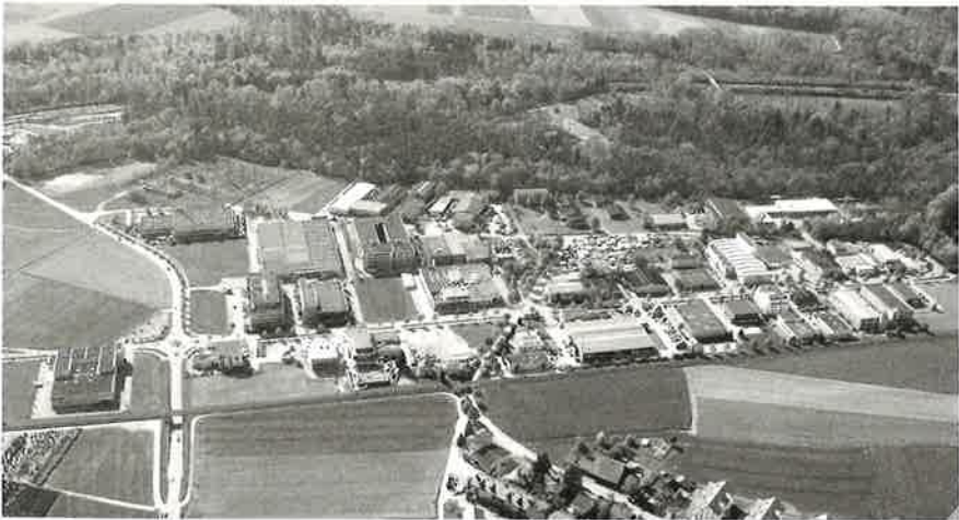
Die Planung der Industriezone Süd (früher Industrie Grien genannt) zwischen Lyss und Aarberg, Alter Aare und Bahnlinie Richtung Aarberg wurde Mitte der Siebzigerjahre erarbeitet und seither schrittweise verwirklicht.
