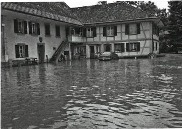
Überschwemmung im Hof der mittleren Mühle.
