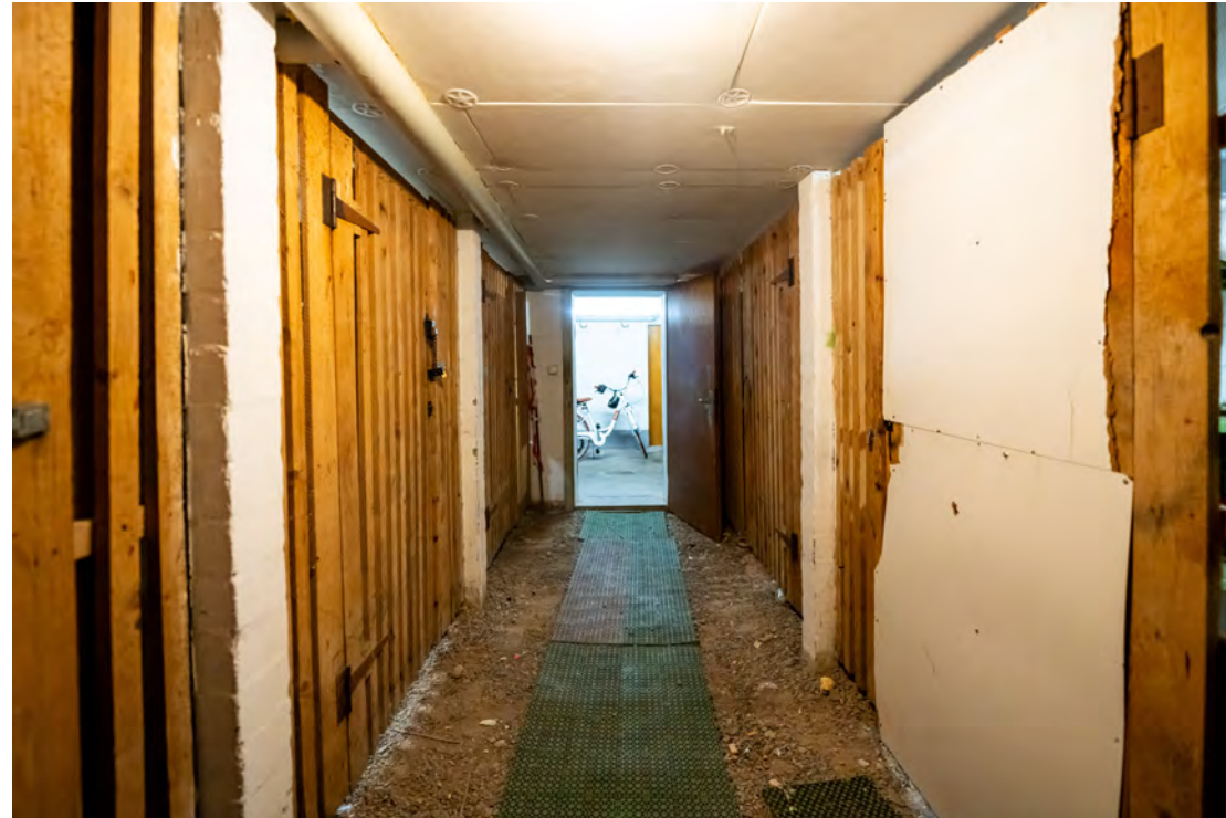
Kellerräume - Teilweise mit Naturboden
