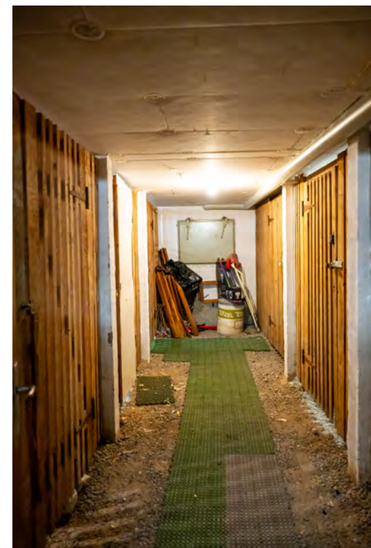
Kellerräume - Teilweise mit Naturboden
