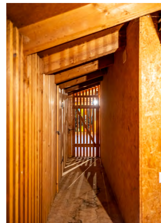
Estrich mit Sparrenlage
