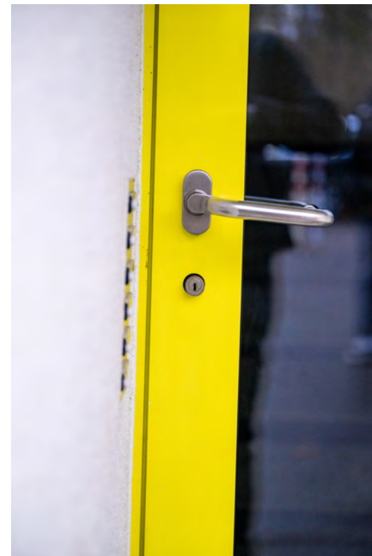
Detail Türfalle mit Putzsaden
